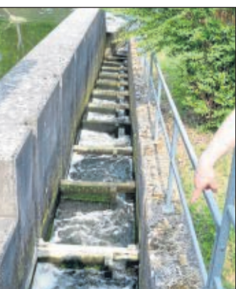
Treppe für die Fische: Die Tiere werden an der Schabe vorbeigeleitet.
