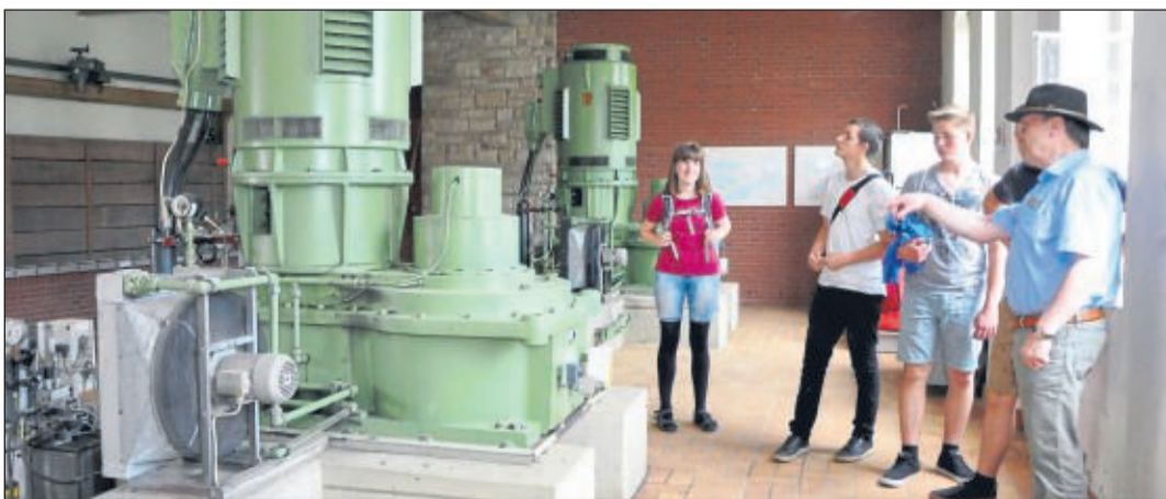
Technik in altem Gemäuer: Gerhard Fischer von den Stadtwerken zeigte den Neuntklässlern die Turbinen und erklärte die Technik.
